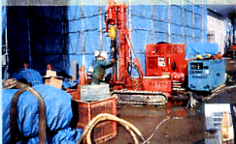
ホーリングして地面に孔を掘ります
