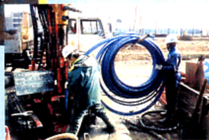
ホーリングした孔にパイプを設置
